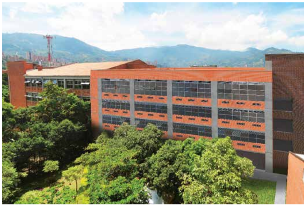
La renovación del edificio de La Primaria (2018).
